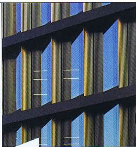
Hinter den goldfarbene Schallabsorber-Lamellen sind schmale, öffnere Fensterflügel. Die großen Scheiben sind Festverglasungen.
