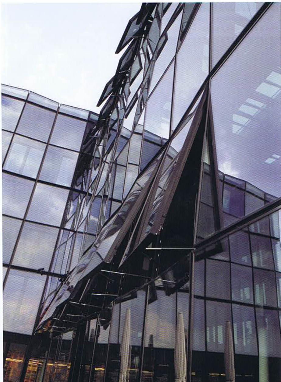
Abbildung 4: „Jumbo“-NRWG-Klappfenster mit Hydraulik-Antrieben. Größe ca. 2,7 m x 4,1 m (B x H).
