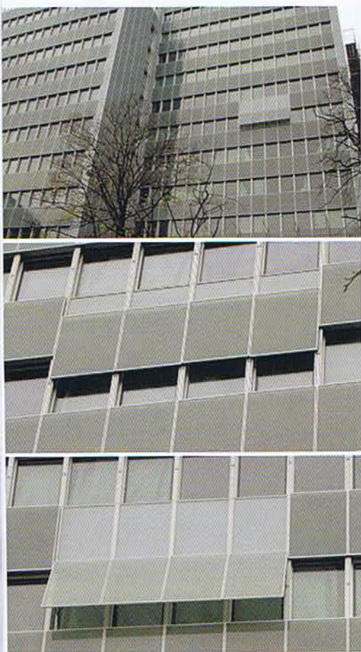
Abbildung 3: Windsicheres Sonnenschutz-Glasschild mit 400 Volt Zahnstangen-Antrieben. Das Glaschild kann ca. 1,8 m aus der Parkstellung im Bereich der Brüstungen nach unten vor die transparenten Fensterelemente gefahren werden. In der unteren Endstellung kann das Glaschild zusätzlich nach außen geschwenkt werden.
