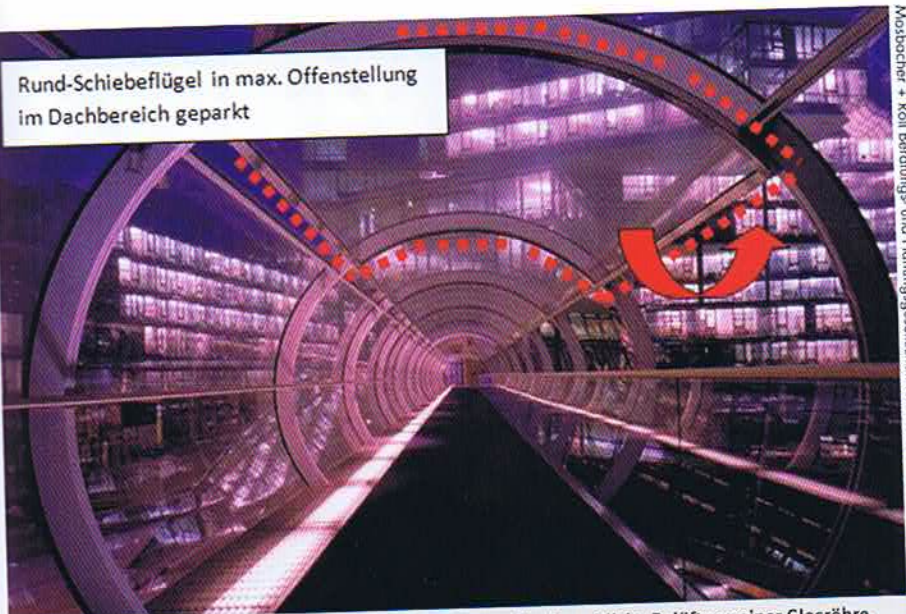
Abbildung 2: Elektro-mechanischer Öffnungsmechanismus für die seitliche Belüftung einer Glasröhre. Einzelne gebogene Glassegmente können mit Hilfe eines Getriebemotors und mit einem in die gerundeten Pfostenprofile verdeckt eingebauten Beschlag stufenlos in den Dachbereich der Glasröhre gefahren werden.
